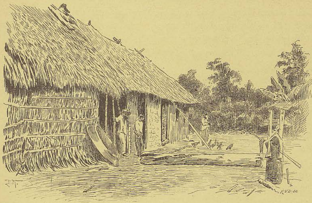
Casa de José da Costa à Arrependido (Itaboca).
