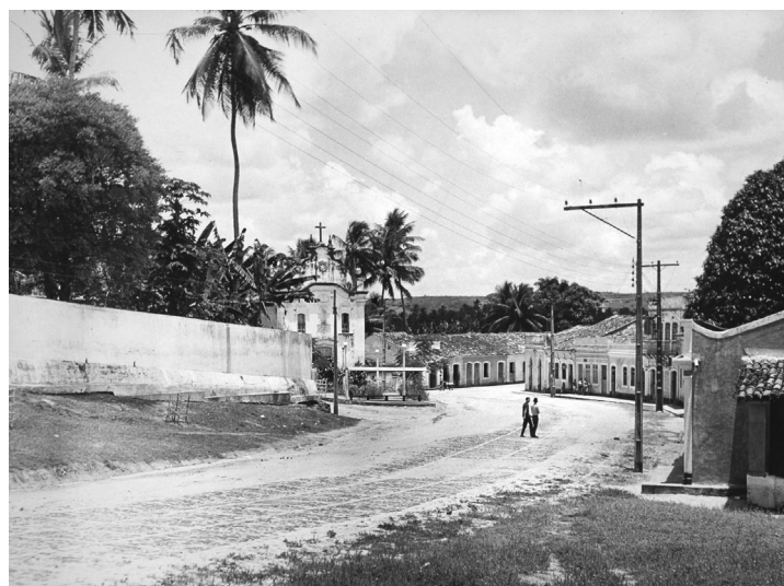
SILVA TELES, Augusto C. Casa na Rua Dantas Barreto, 1969. Arquivo Central do IPHAN – Seção Rio de Janeiro.
