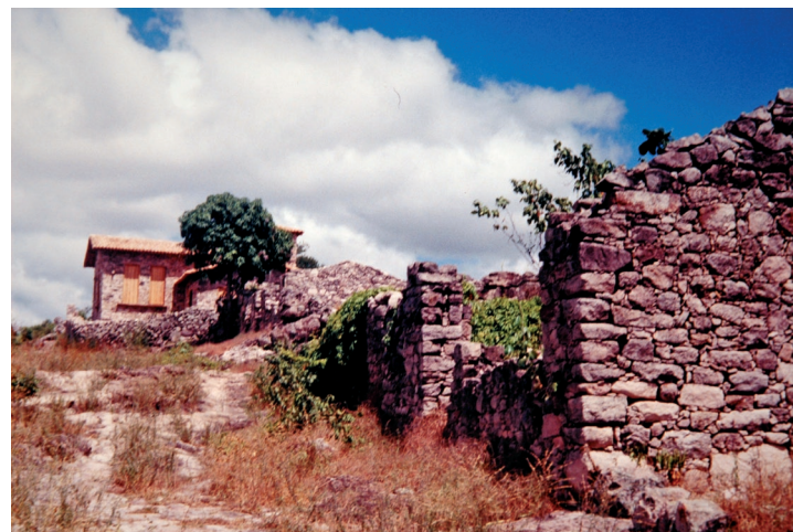
Ruínas na Rua do Cumbuco, Igatu. Arquivo Central do IPHAN – Seção Rio de Janeiro.
