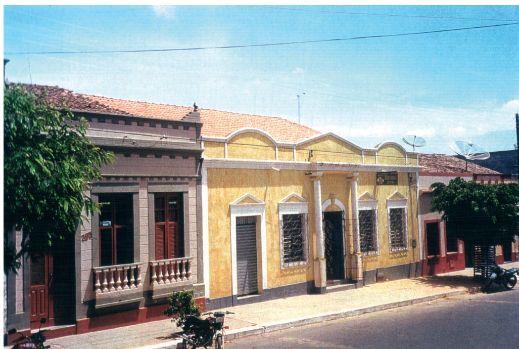
Rua Lamartine Nogueira, Viçosa. Arquivo Central do IPHAN – Seção Rio de Janeiro.
