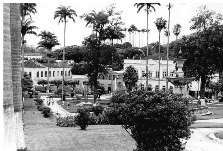
CALVENTE, Eurico. Casa à Rua Barão de Vassouras, nº 33. Fachada do prédio do Fórum – Praça Barão de Campo Belo, Vassouras, 1977. Arquivo Central do IPHAN – Seção Rio de Janeiro.
