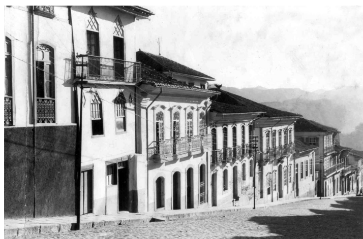
HESS, Erich. Casas à Rua Conde de Bobadela, Ouro Preto. Arquivo Central do IPHAN – Seção Rio de Janeiro.
