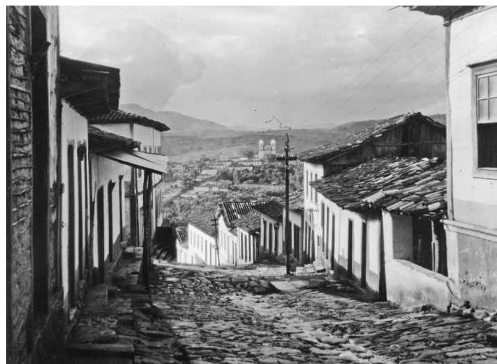
STILLE. Vista do conjunto arquitetônico e urbanístico de Congonhas. Arquivo Central do IPHAN – Seção Rio de Janeiro.
