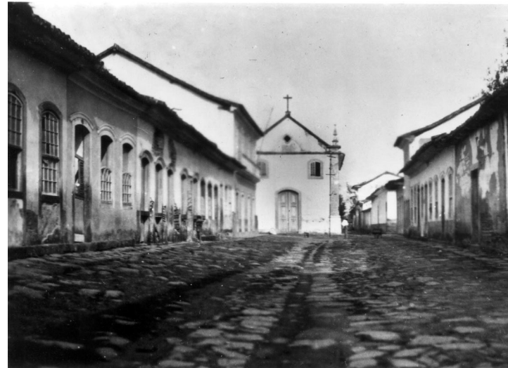
Vista do conjunto com igreja do Rosário ao fundo. Arquivo Central do IPHAN – Seção Rio de Janeiro.
