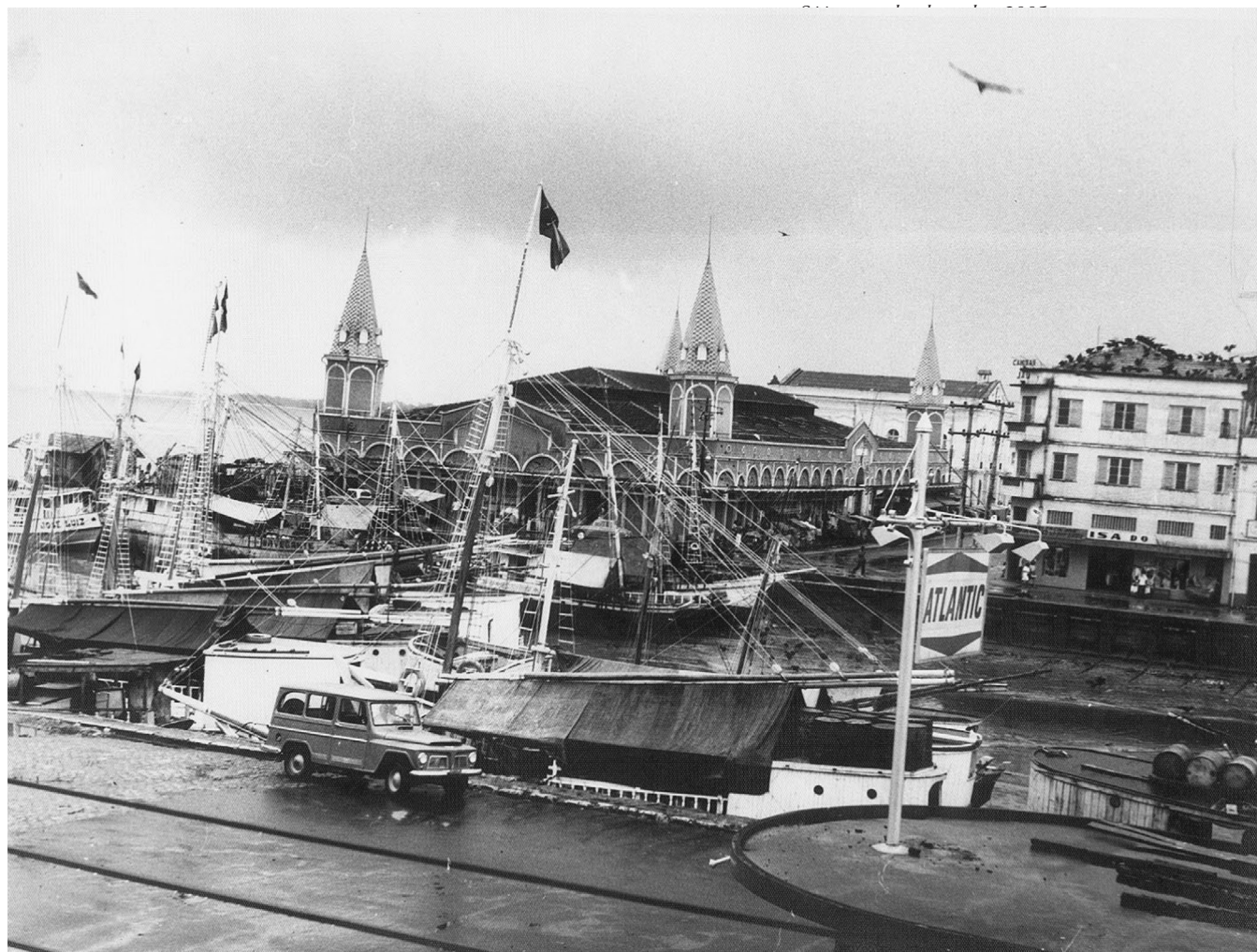
A Doca do Ver-o-Peso, Belém (PA), 1969. Arquivo Central do IPHAN – Seção Rio de Janeiro.
