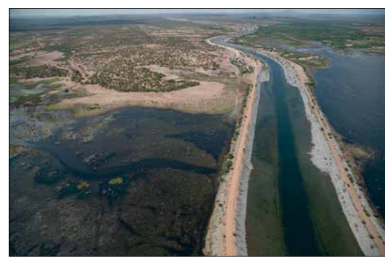
Canal parte de dentro do São Francisco rumo à Paraíba: obra inaugurada em março
