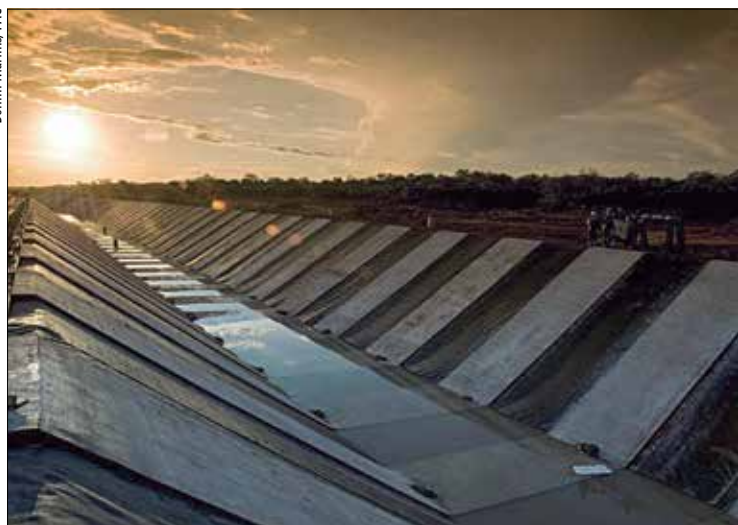
Obras de transposição do Rio São Francisco em Cabrobó, em Pernambuco
