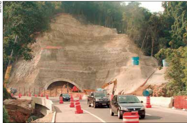
Obra na subida da Serra de Petrópolis é considerada irregular pelo TCU
