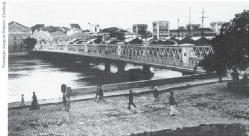
Ponte da Boa Vista, ligando o bairro de Santo Antônio ao da Boa Vista, no Recife.
