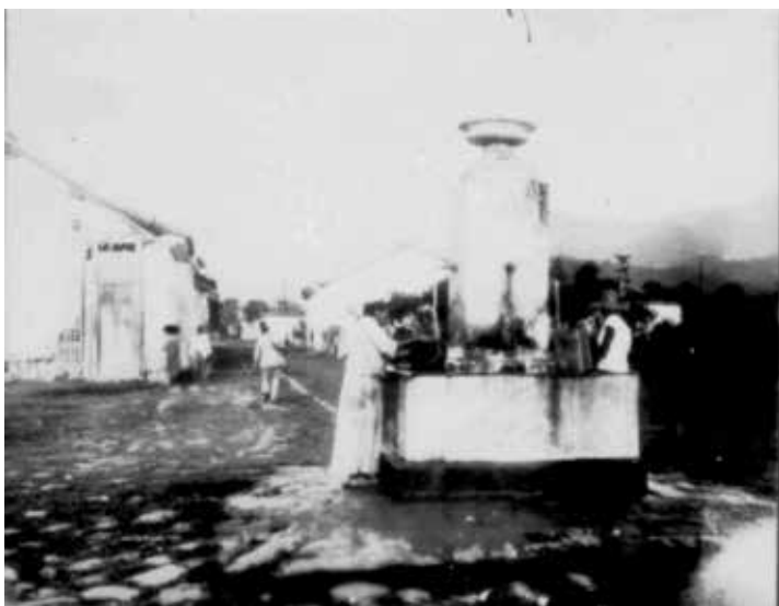
Vista do Chafariz da Pedreira. Sem autor, sem data.
