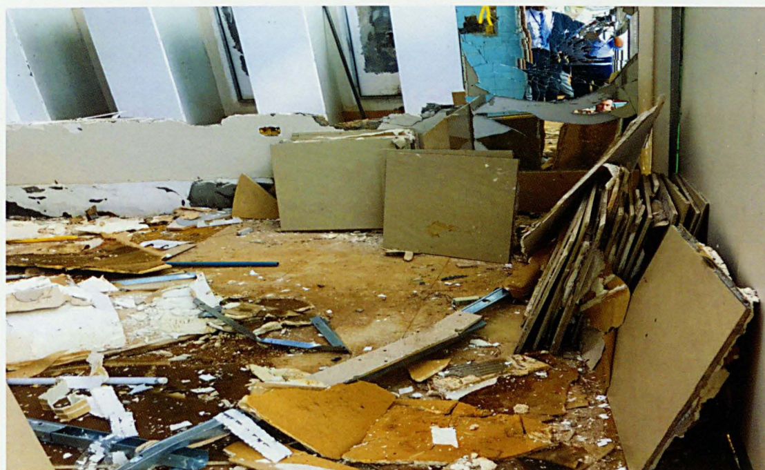
Estado de conservação de banheiros e vestiários.
