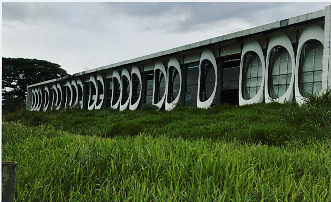
Estado de conservação da fachada.
