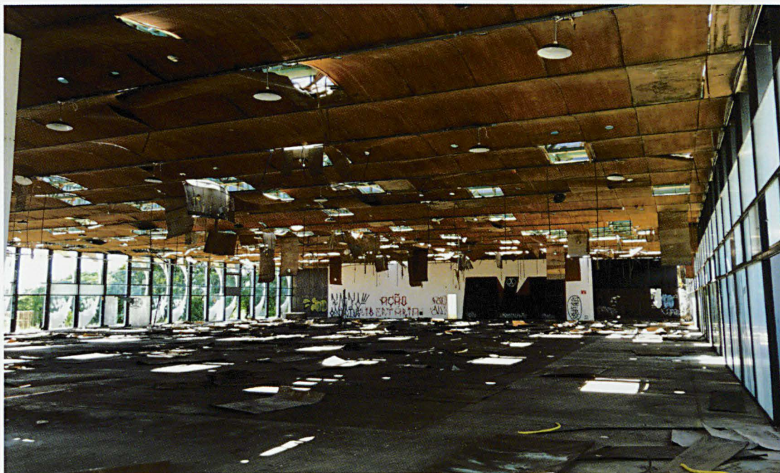
Estado de conservação do Salão.
