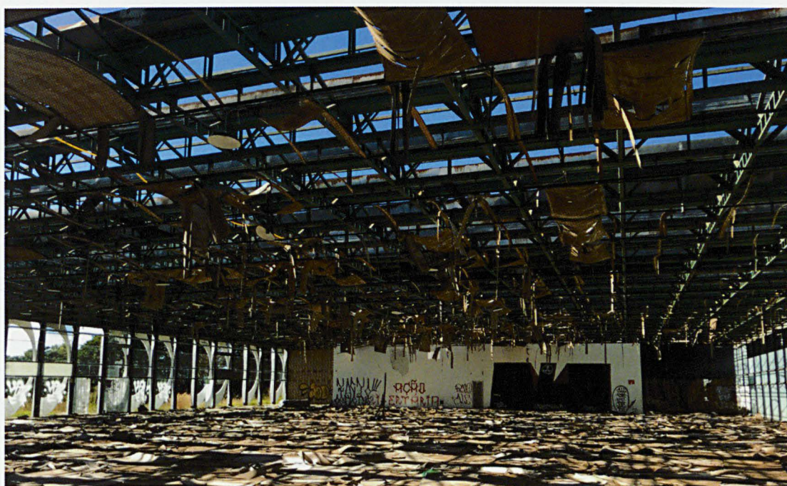
Estado de conservação atual do Salão.
