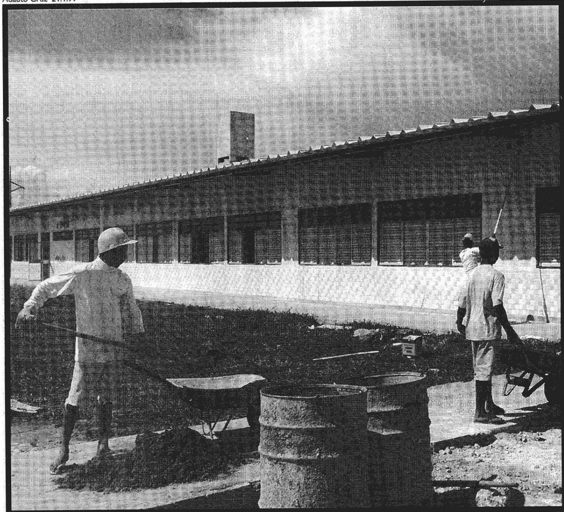
OBRAS SOCIAIS, COMO INVESTIMENTOS EM ESCOLAS, TERÃO MAIS DINHEIRO RESERVADO NO ORÇAMENTO DO PRÓXIMO ANO
