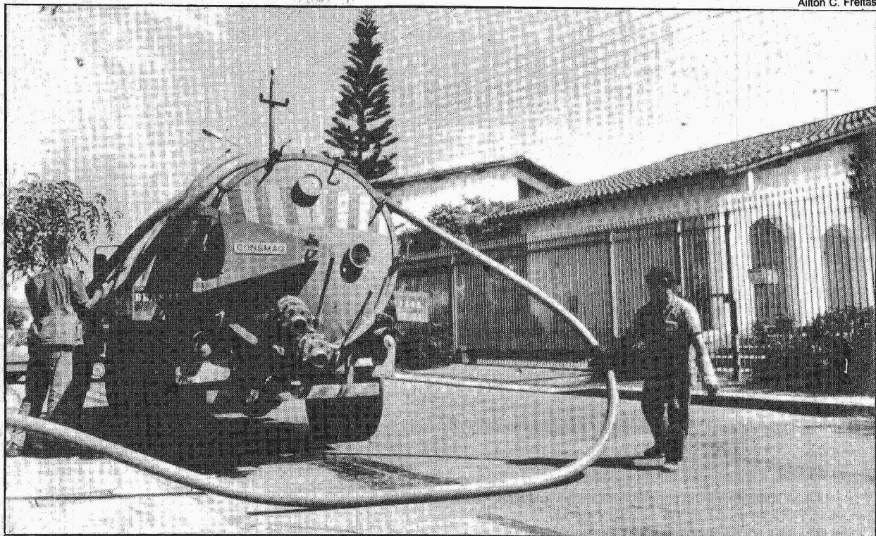
Casas do Lago usam fossas sépticas, que são limpas regularmente, por falta de rede de esgoto
