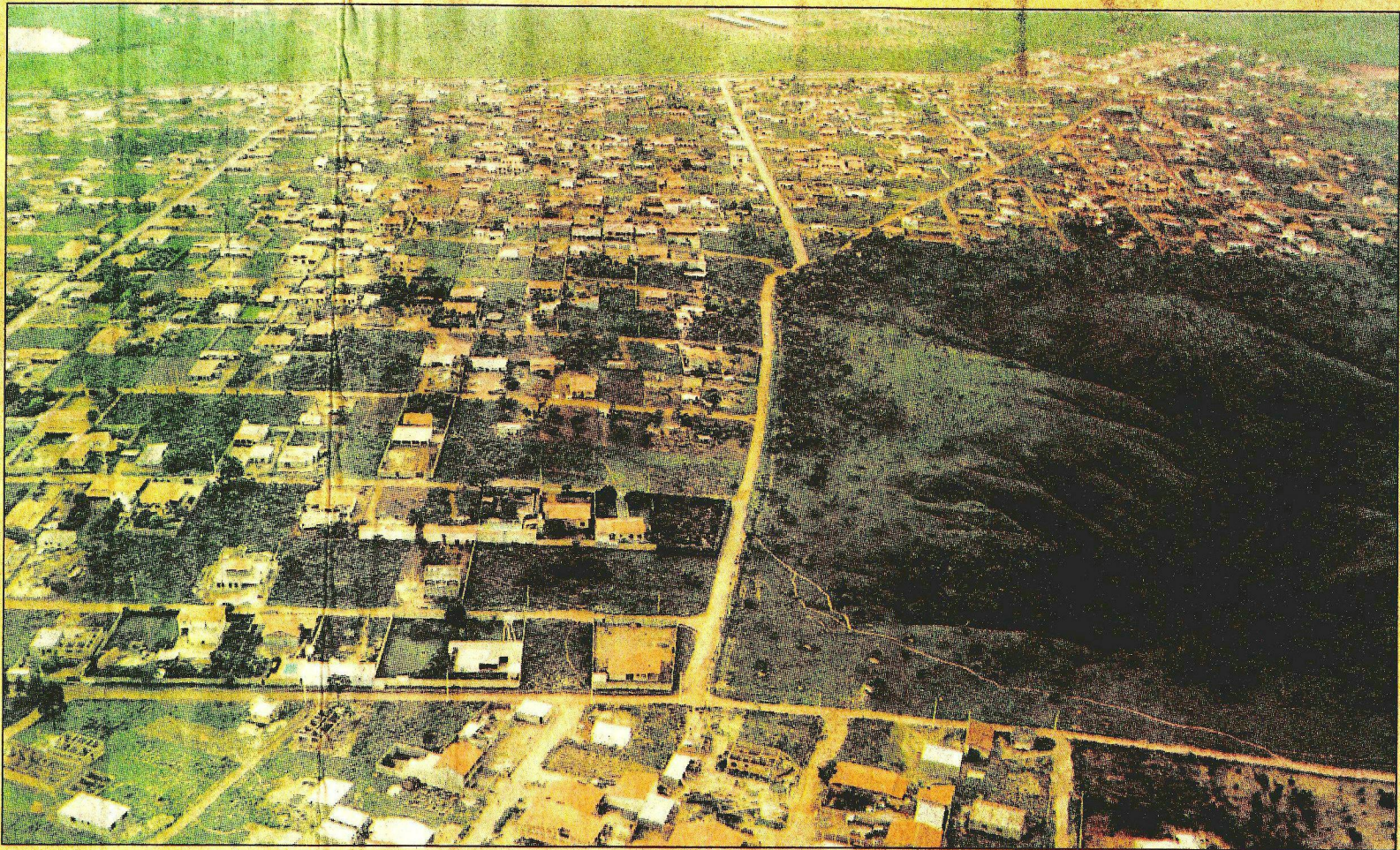
O condomínio faz fronteira com uma área de relevo geográfico irregular e repleta de nascentes, que tende a causar erosão no solo com o passar dos anos
