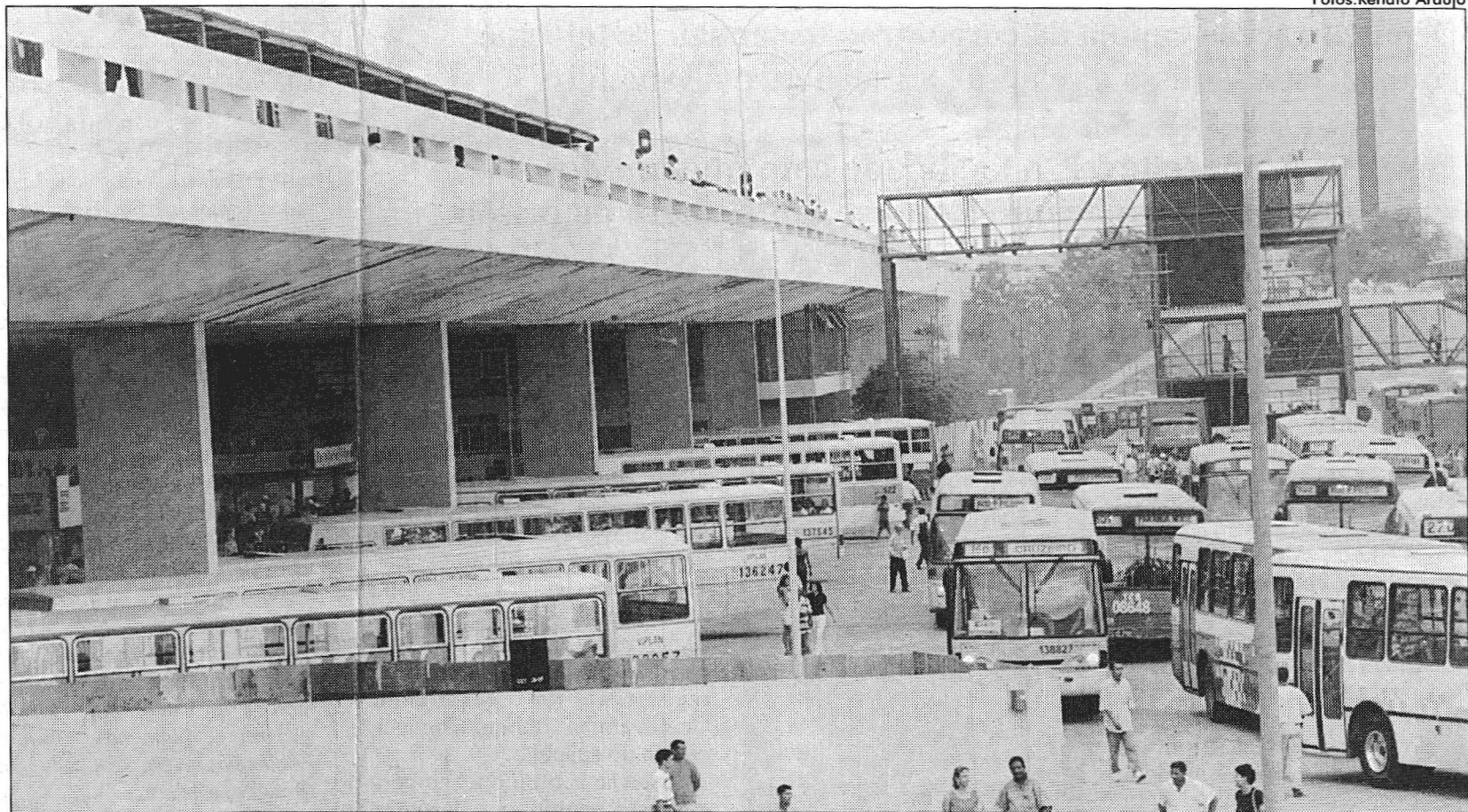
A PARTIR da próxima segunda-feira, a Secretaria de Obras vai promover novas alterações nos terminais de ônibus
