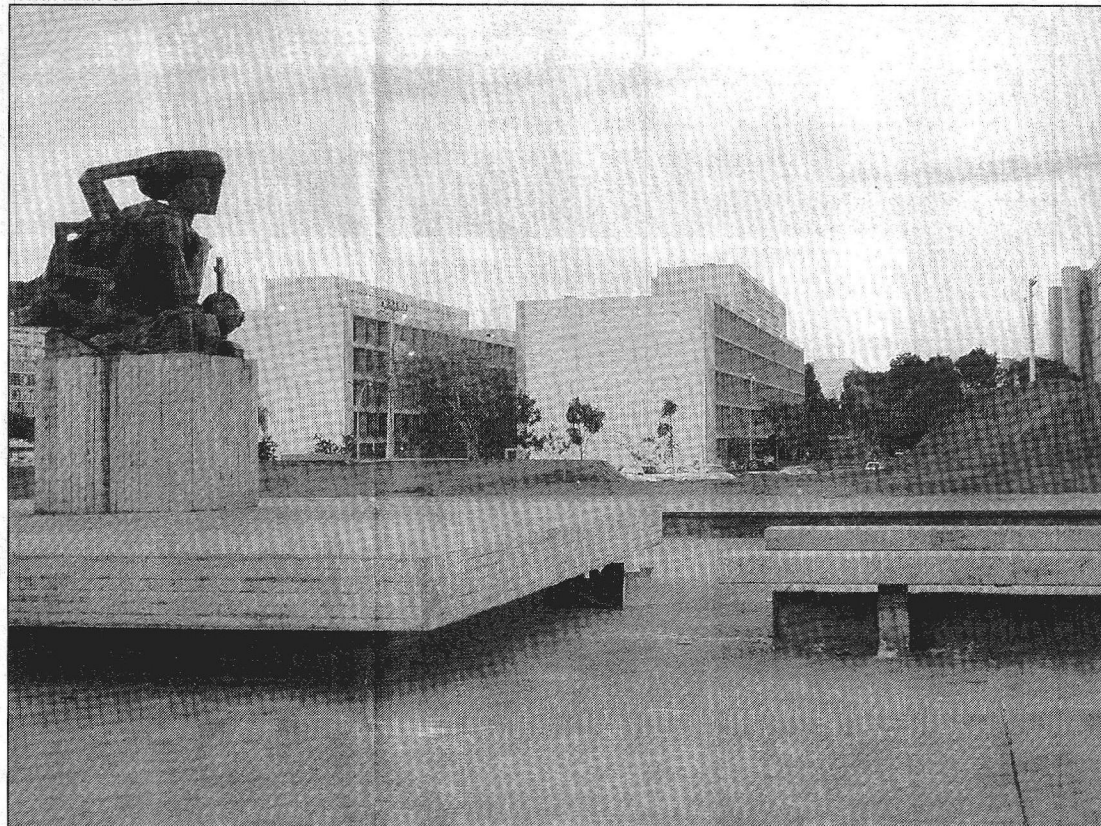
A Praça Portugal, construída nos anos 60, já está em obras e deve ser reinaugurada no mês que vem
