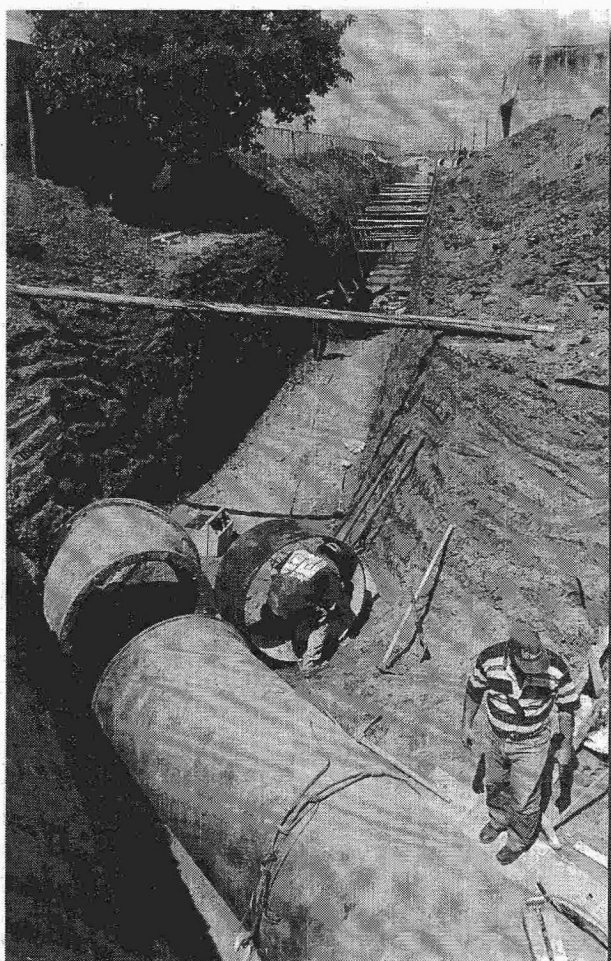
As ligações condominiais despejam o esgoto na rede coletiva
