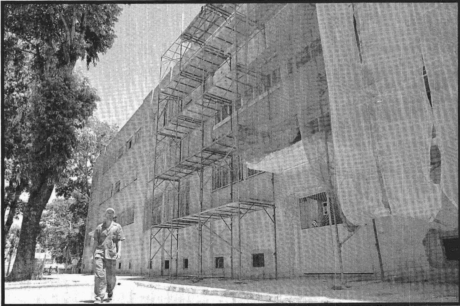
REFORMA DA FACHADA DO PRÉDIO DA 410 SUL REDUZIU AS INFILTRAÇÕES. OS CANOS DE METADE DOS 24 APARTAMENTOS FORAM TROCADOS
