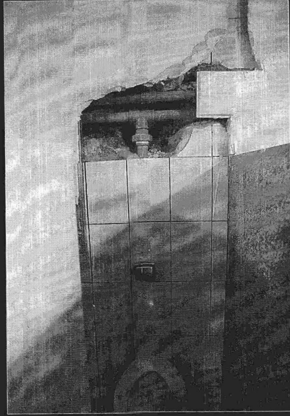
O afundamento do piso, infiltrações e pastilhas soltas são alguns dos problemas, detectados pelo laudo, que serão corrigidos com as obras
