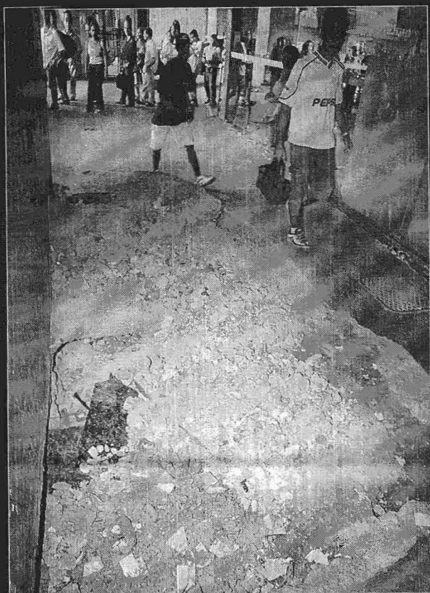
O afundamento do piso, infiltrações e pastilhas soltas são alguns dos problemas, detectados pelo laudo, que serão corrigidos com as obras
