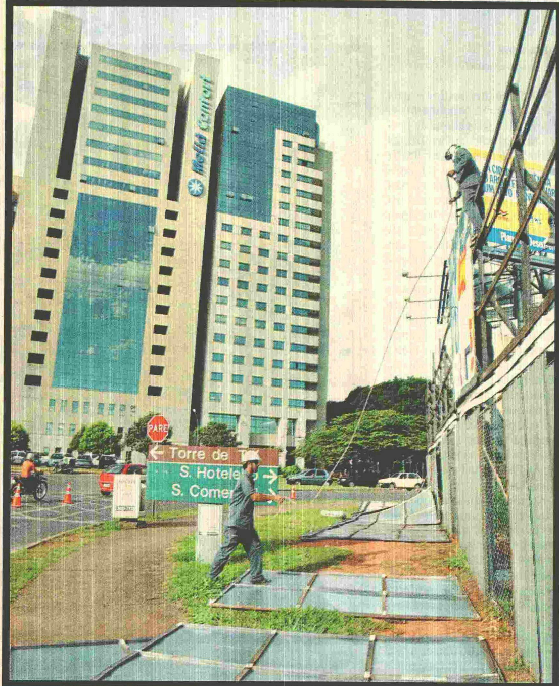
A DERRUBADA DOS OUTDOORS COMEÇOU PELO SETOR COMERCIAL SUL, NO TERRENO ONDE FUNCIONARIA A BI BA BÔ
