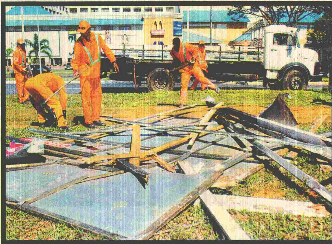
ENQUANTO FUNCIONÁRIOS DESMONTAVAM OS PAINÉIS, REPRESENTANTES DAS EMPRESAS RECLAMAVAM
