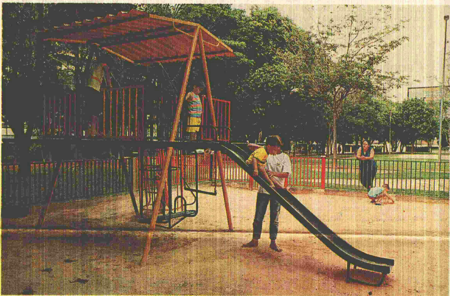
■ NA 306/307 NORTE, O PARQUINHO ESTÁ EM BOAS CONDIÇÕES E APARENTEMENTE NÃO OFERECE RISCO ÀS CRIANÇAS QUE DESFRUTAM DO LOCAL
