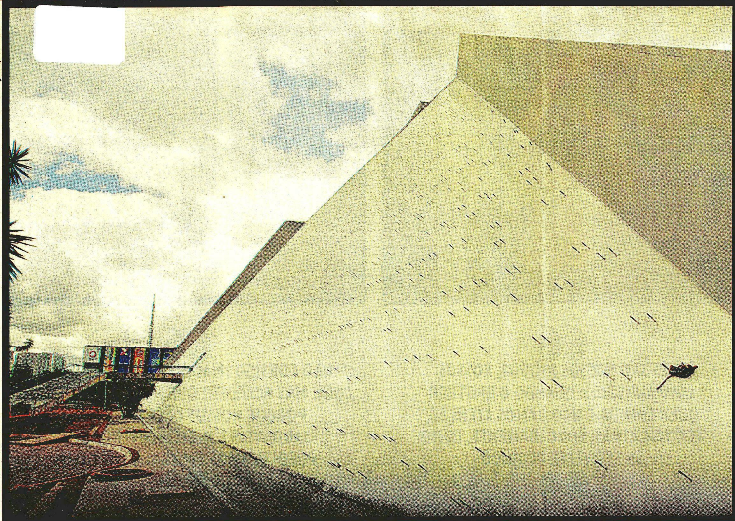
FACHADA LISA, SEM A OBRA ASSINADA POR ATHOS BULCÃO: DO LADO SUL, HAVIA 1.693 BLOCOS DE CONCRETO. ELES ESTAVAM ENFERRUJADOS E CORROÍDOS
