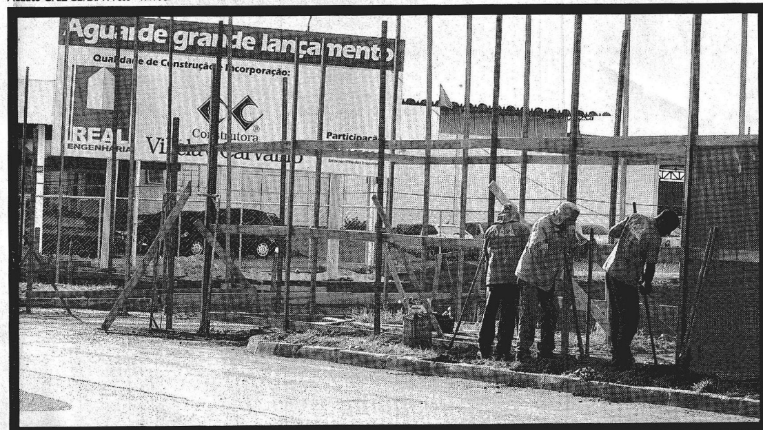
ESTANDES DE VENDAS JÁ OFERECEM APARTAMENTOS DE LUXO AO LADO DO CASA PARK: PRÉDIOS TERIAM ATÉ 19 ANDARES
