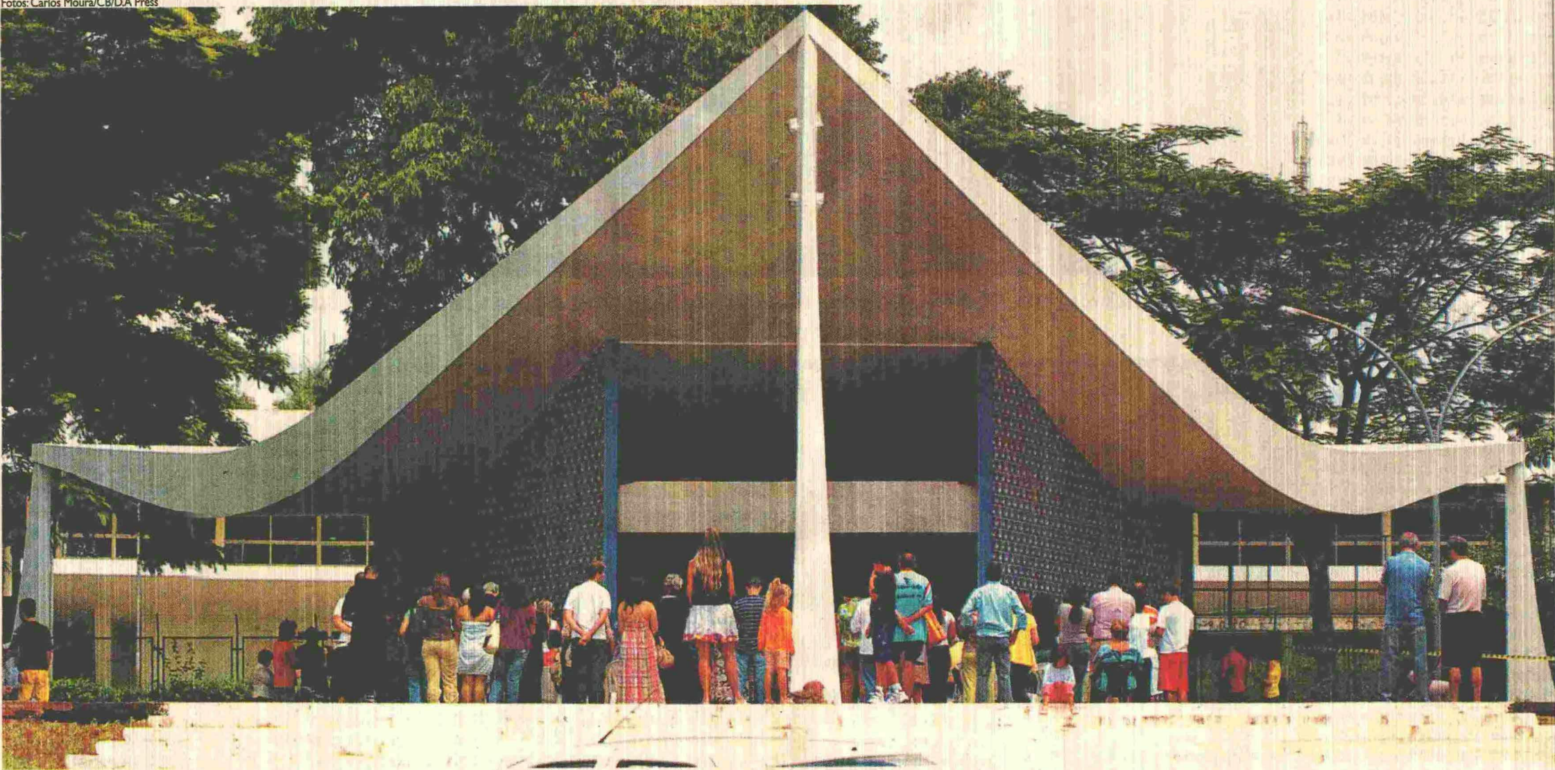
FIÉIS ASSISTEM À MISSA NA MANHÃ DE ONTEM: RECUPERAÇÃO INCLUI MELHORIA DAS ESCADAS DE ACESSO À IGREJA, DO PISO, REVISÃO DAS INSTALAÇÕES ELÉTRICAS, PINTURA, CONSTRUÇÃO DE UM ALTAR, ALÉM DA TROCA DAS PEÇAS DE BULCÃO
