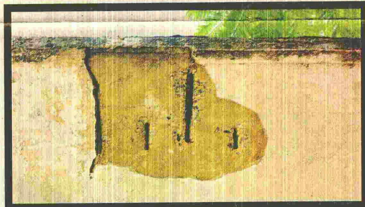
IRREGULARIDADES NAS ESTRUTURAS: CORROSÃO QUE DEIXA O FERRO À MOSTRA E INCLINAÇÃO INADEQUADA
