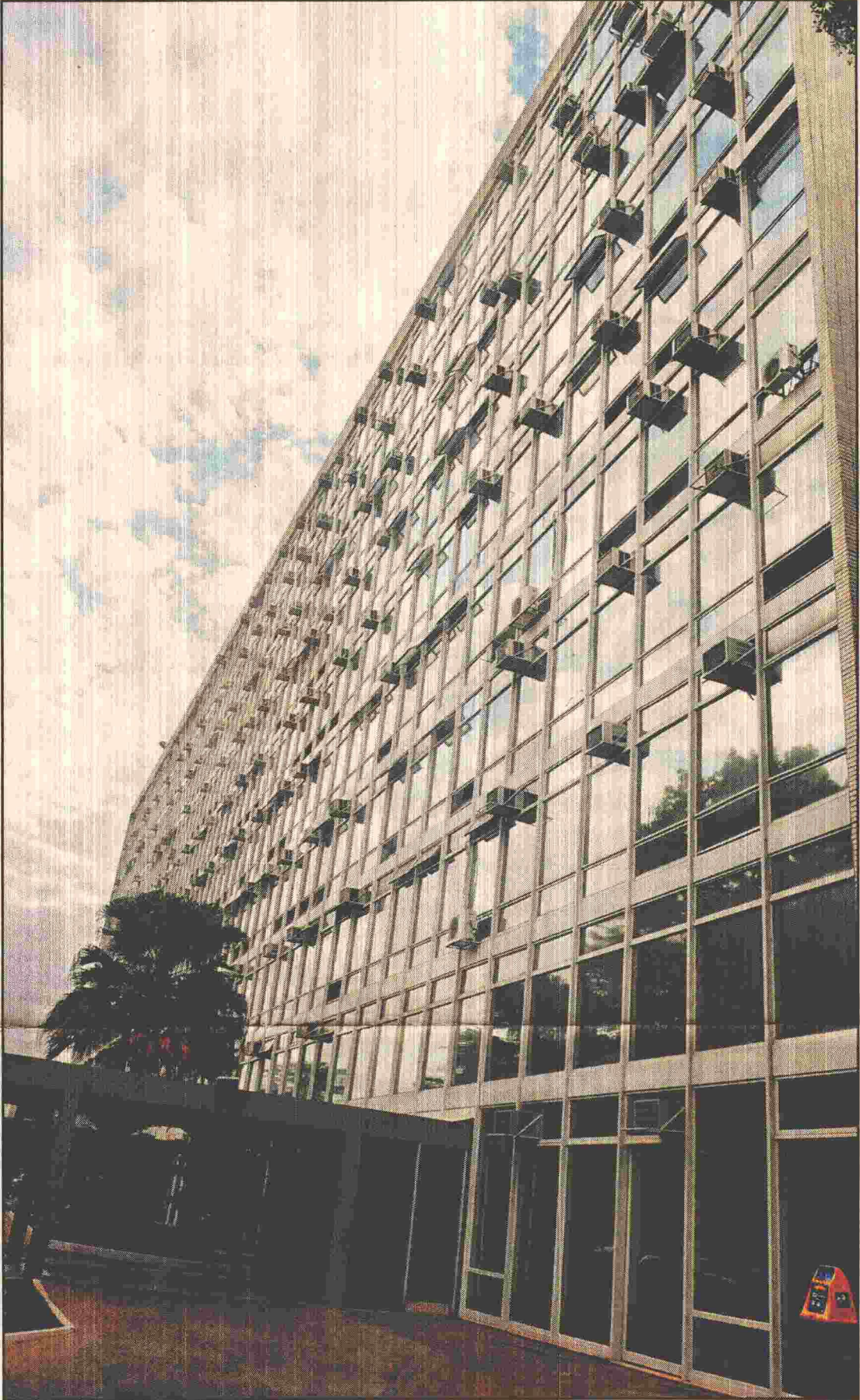
A instalação de aparelhos de ar condicionado altera o projeto original da cidade: falta de planejamento
