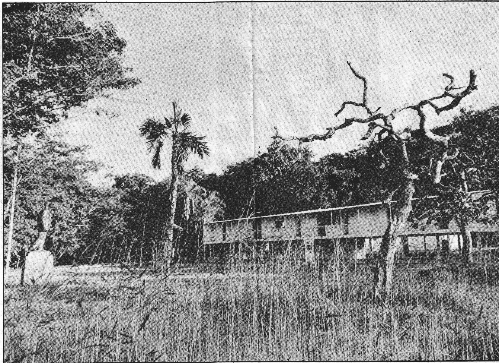
O Catetinho, primeira residência oficial de JK, está abandonado e sofre a devastação de cupins e traças, que corroem sua estrutura
