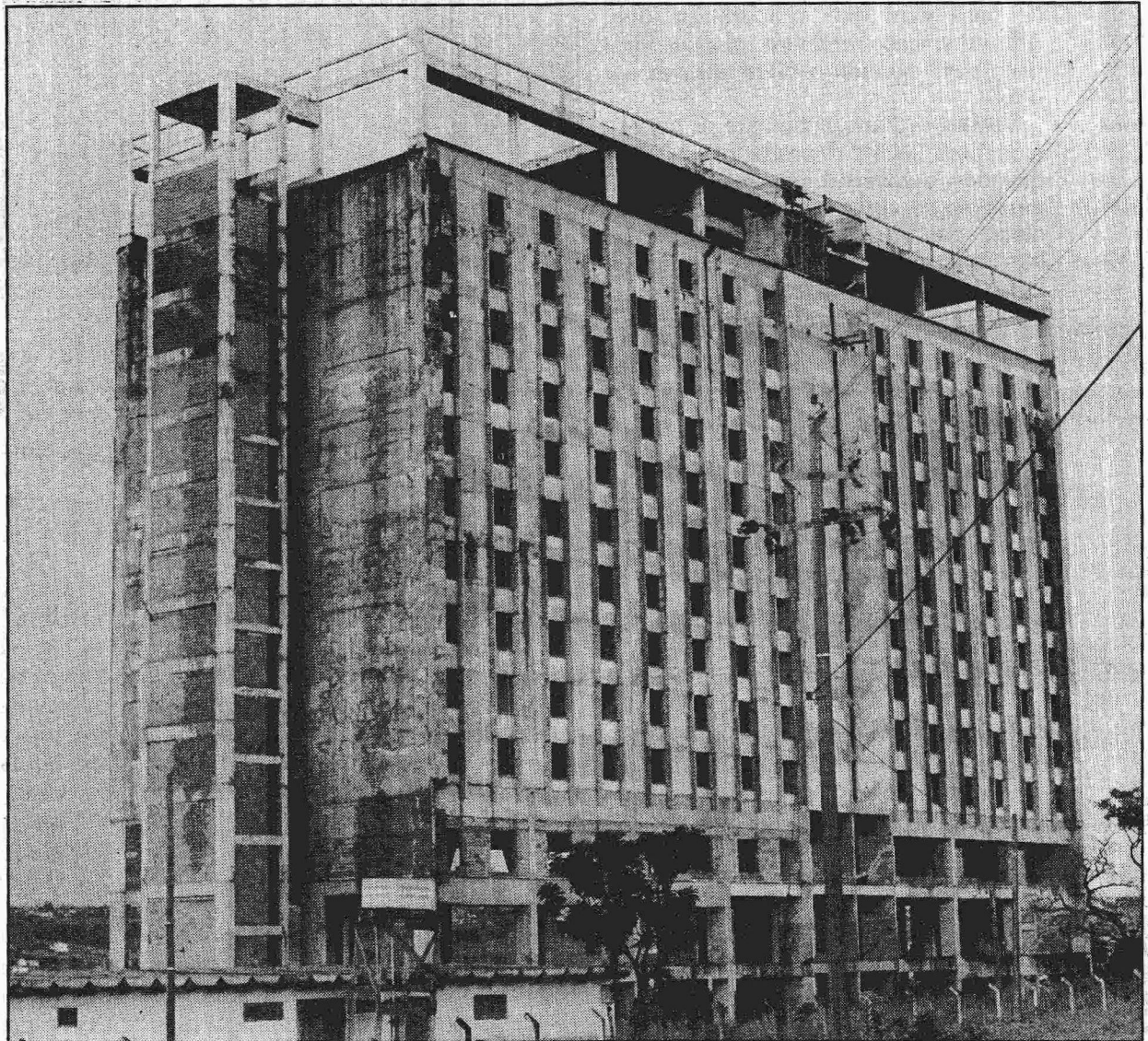
Várias das construções inacabadas espalhadas pela cidade já estão com seus destinos definidos
