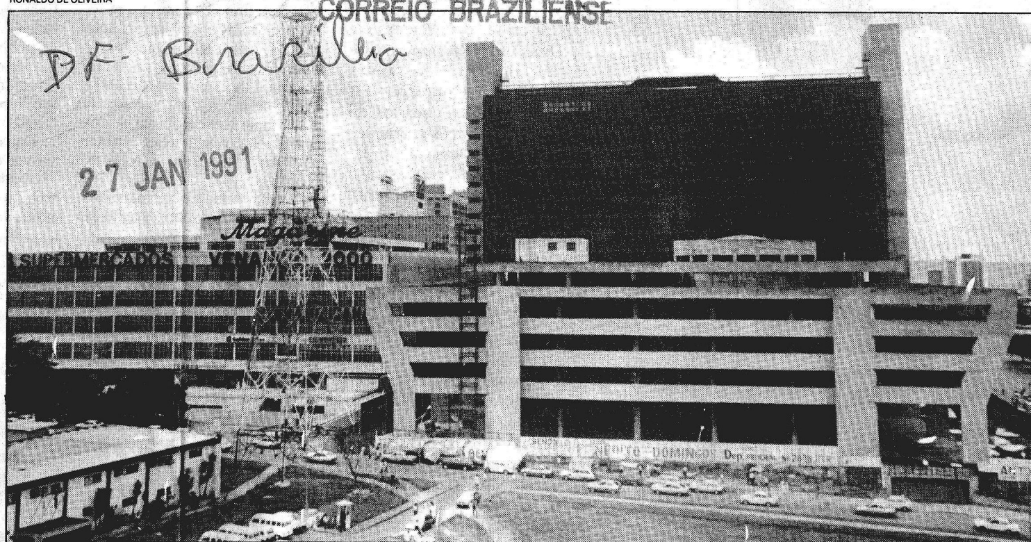
O Shopping Baracat foi embargado pela Terracap porque a obra não respeitou os limites do terreno
