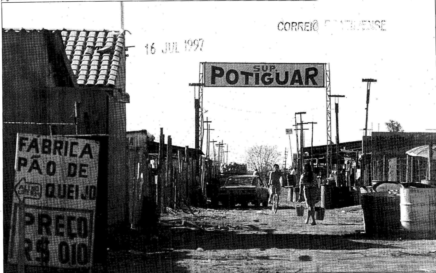
A invasão da Estrutural começa a mudar de vida a partir da construção de um quartel que vai abrigar a administração do local. Parte da área será cercada
