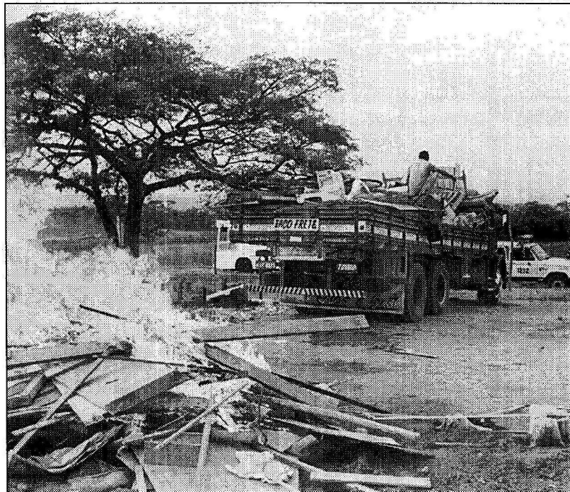
A madeira usada nos barracos foi queimada após a derrubada
