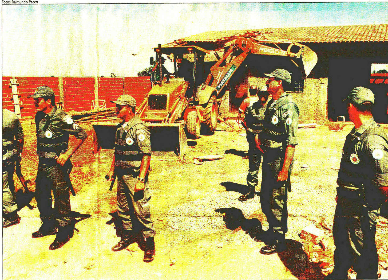
A demolição no Condomínio Hollywood envolveu a participação de 40 policiais militares e 100 funcionários de diversos órgãos do GDF, além máquinas
