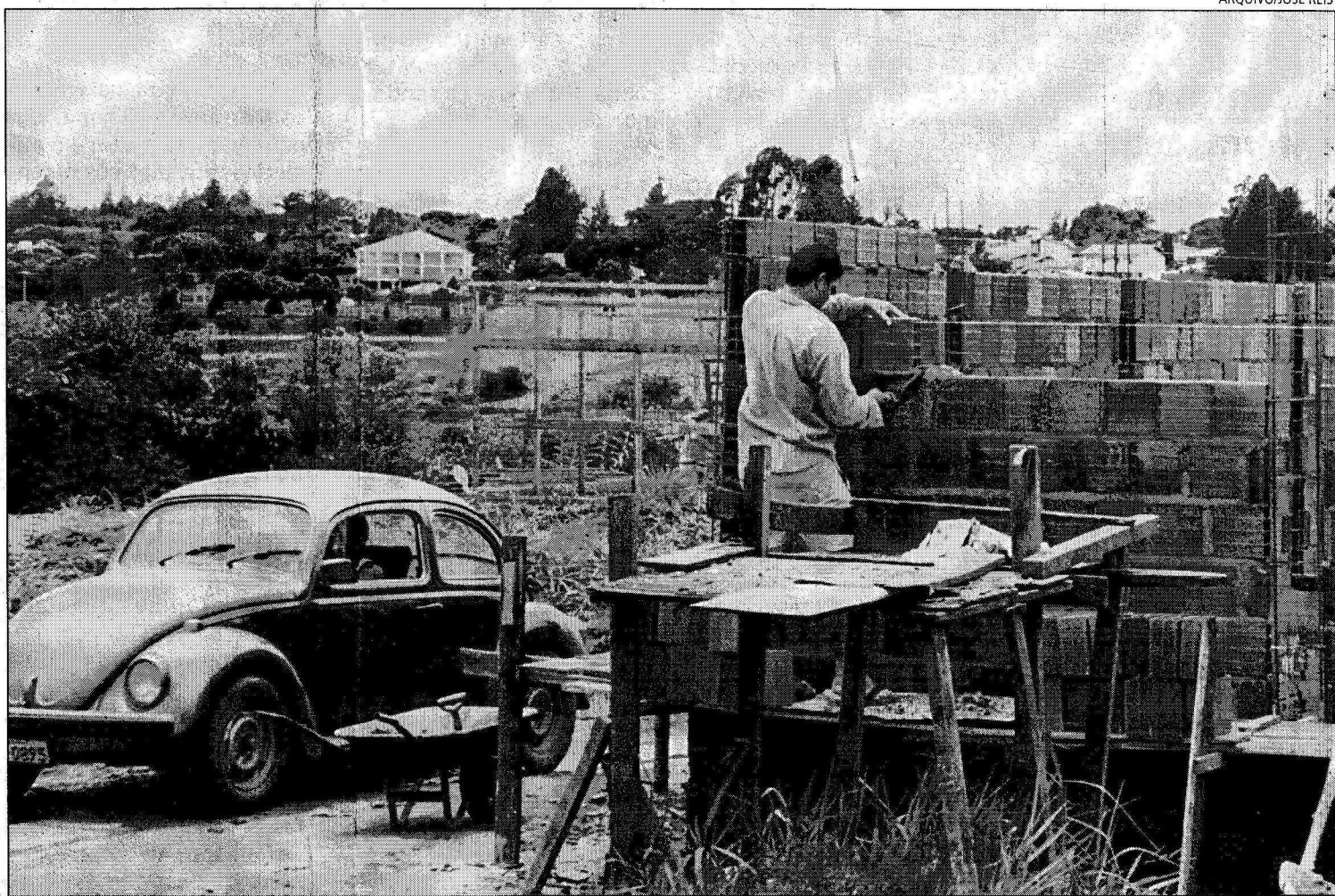
ANTIGOS moradores deixaram o acampamento e o caminho livre para novos ocupantes, que ergueram casas de alvenaria
