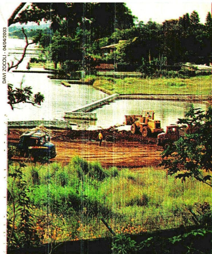
Obra de aterro, um artifício para aumentar a área do terreno
