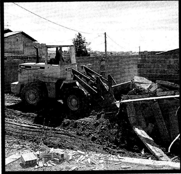
A META ERA DEMOLIR CINCO EDIFICAÇÕES, MAS DUAS JÁ ESTAVAM OCUPADAS
