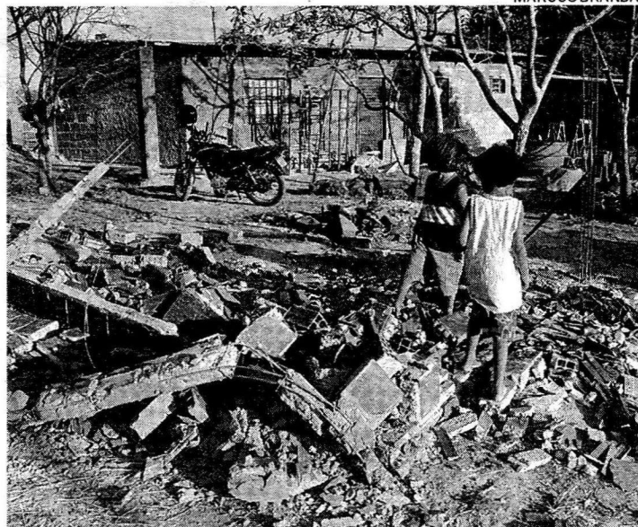
Demolições atingiram só bases de construção e muros
