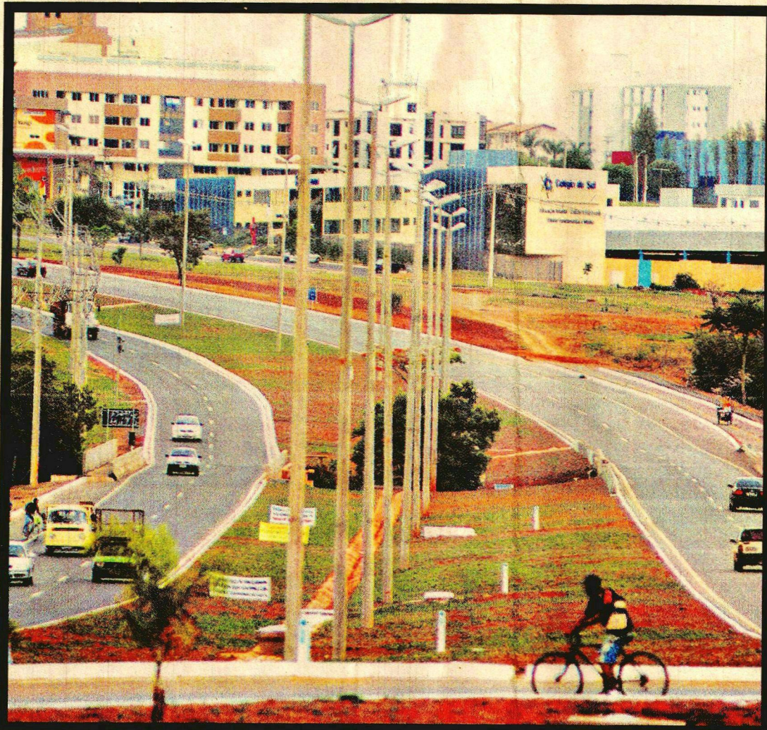
A DF-005 ESTÁ TODA DUPLICADA ENTRE O VARJÃO E O PARANOÁ: OBRA COMEÇOU EM 2005 E CUSTOU R$ 31,4 MILHÕES
