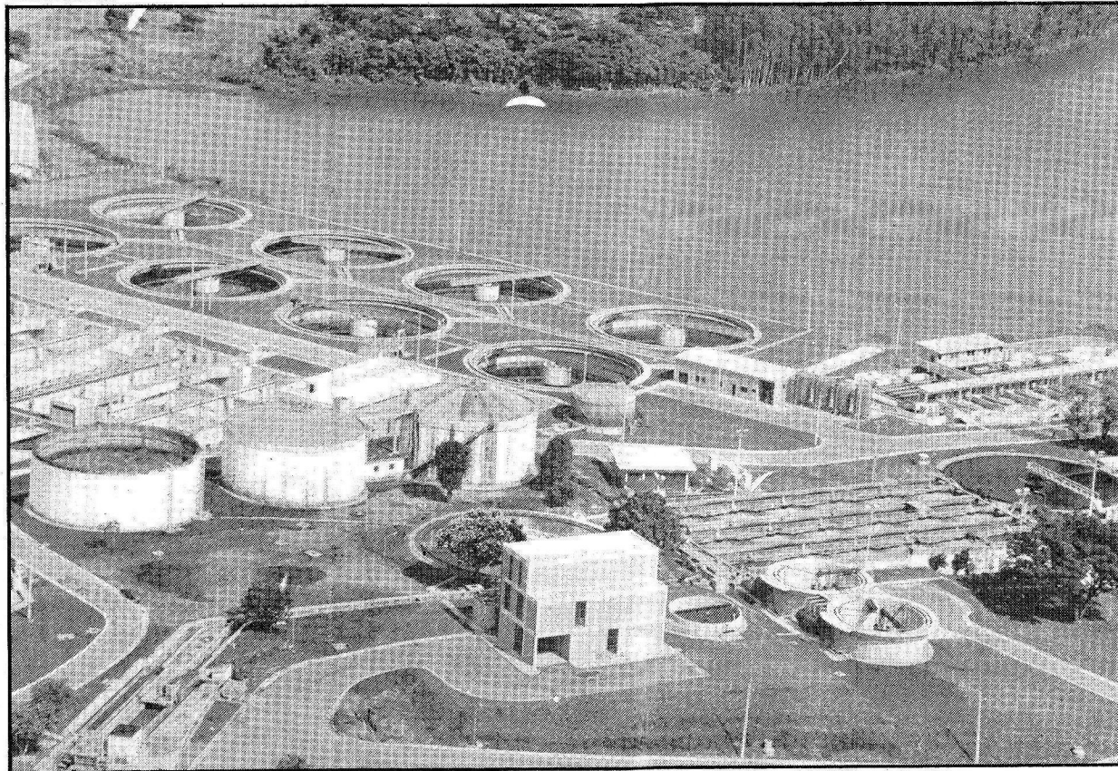
Com suas estações de tratamento de esgoto a Caesb processa 70 mil metros cúbicos por dia
