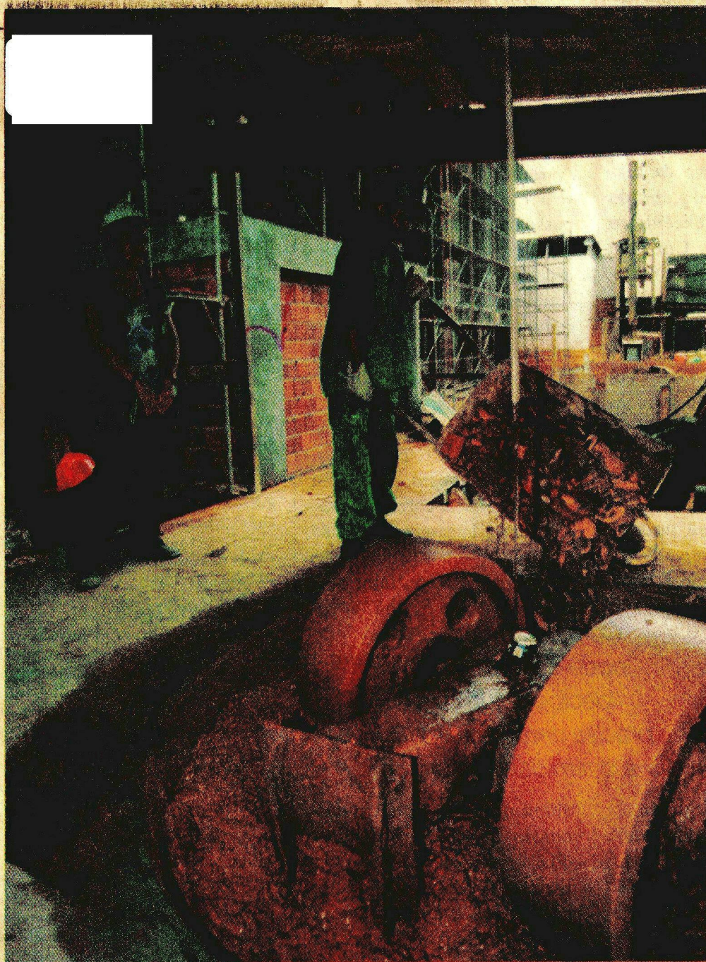
Terezinha: dois sacos de entulho substituem três sacos de areia na composição do reboco
