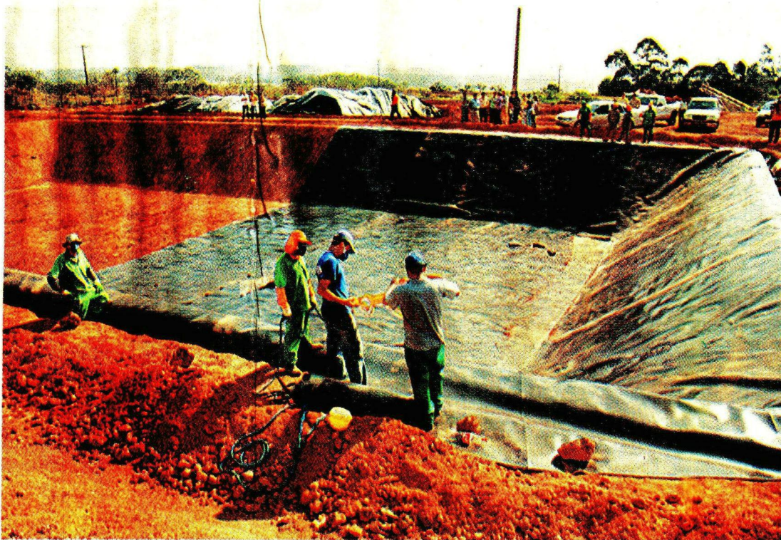
Técnicos colocam lona de PVC na vala construída para captar e tratar o chorume
