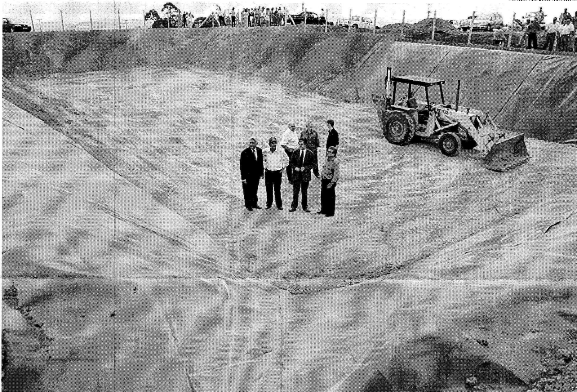
Técnicos do Ibama e do GDF vistoriam e aprovam a vala impermeabilizada que, na madrugada de hoje, começou a receber o lixo hospitalar produzido em todo o DF
