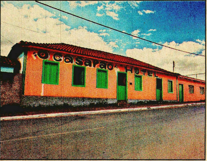
A estrutura do casarão: base que sustenta a construção ainda é de barro
