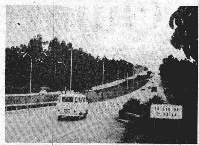
As duas pistas de rolamento da Estrada-Parque Taguatinga, no sentido Plano Piloto-Taguatinga encontram-se completamente recuperadas com nova camada asfáltica. Um tratamento especial foi dado junto aos pontos de ônibus com pavimentação em concreto-armado, enquanto todos os acostamentos foram revestidos, medindo dois metros e meio de largura. Os 160 mil metros quadrados da área gramada estão recebendo aproximadamente 20 mil árvores ornamentais.
