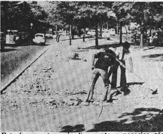
Estacionamentos, ajardinamento e passeios são trabalhos já executados na W/3, concluindo-se assim a primeira etapa das obras
