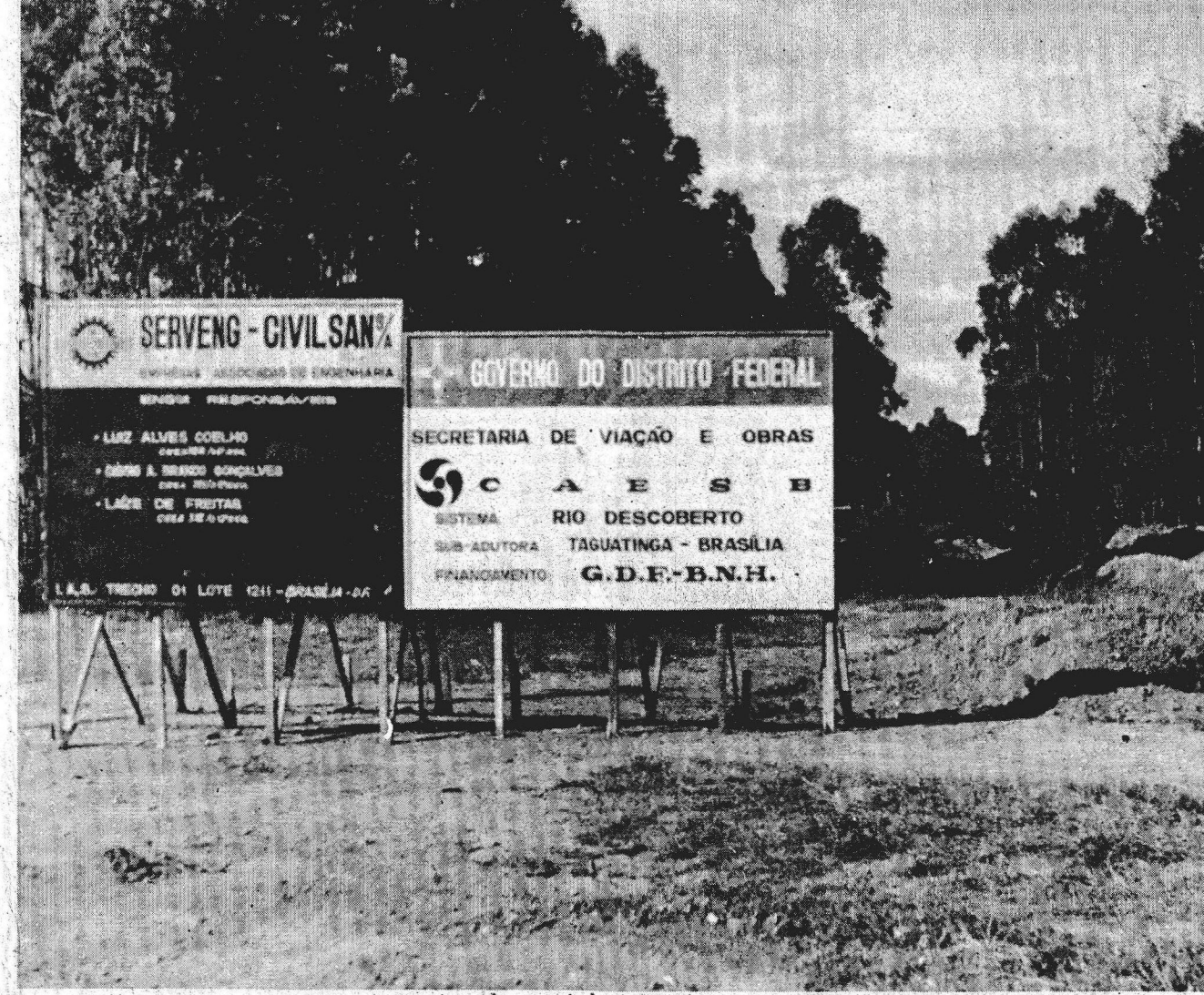
Aspectos do canteiro de obras da CAESB.
