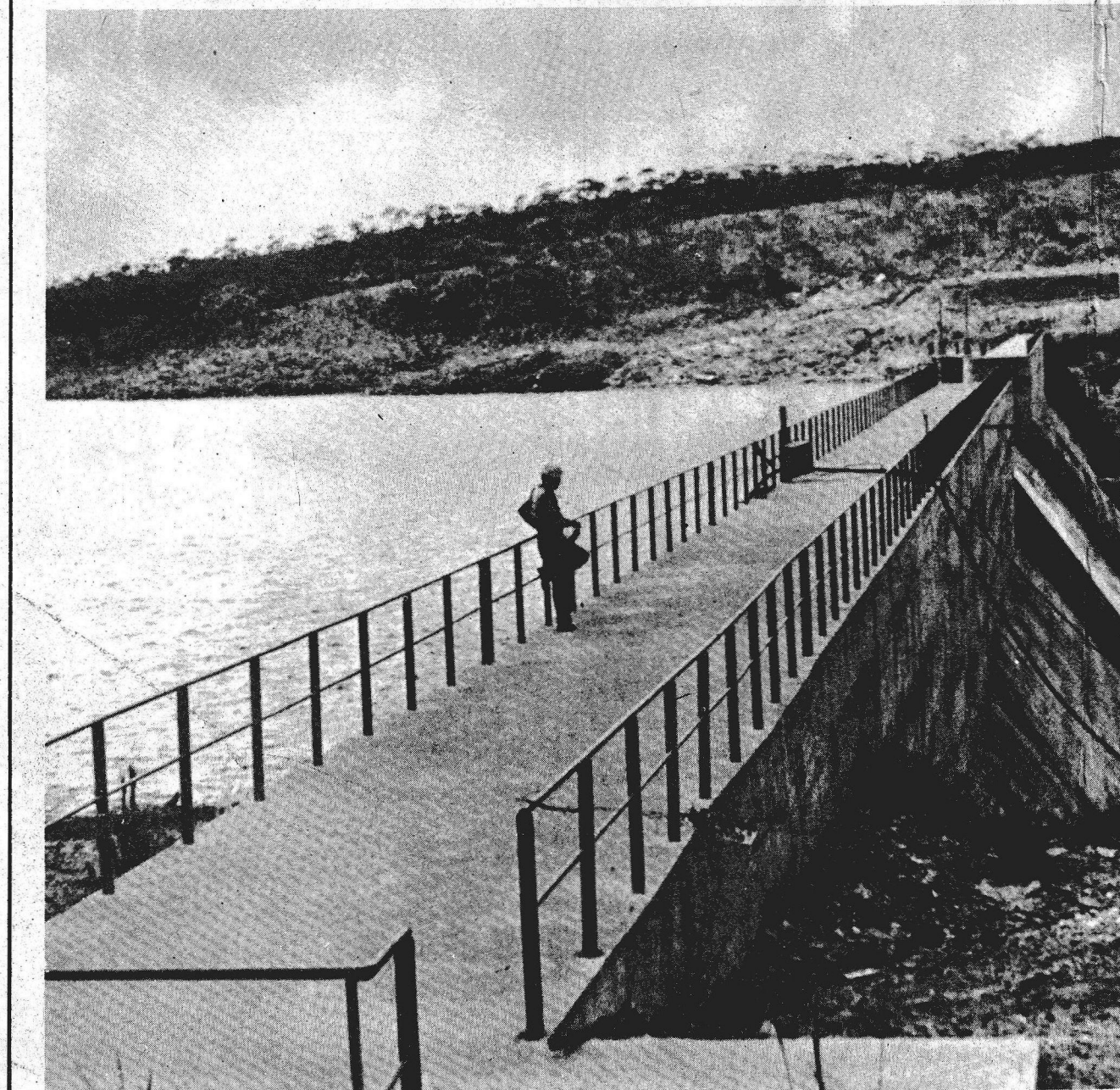
A barragem está pronta
