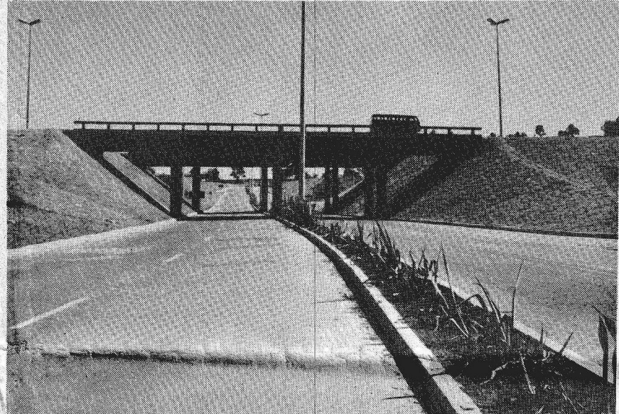
Via de acesso à ponte nº. 2
