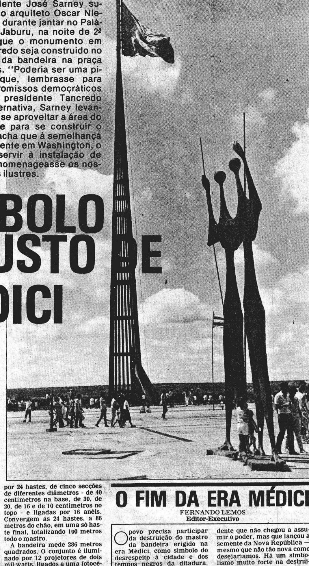
por 24 hastas, de cinco seções de diferentes diâmetros - de 40 centímetros na base, de 30, de 20, de 16 e de 10 centímetros no topo - e ligadas por 16 anéis. Convergem as 24 hastas, a 86 metros do chão, em uma só haste final, totalizando 100 metros todo o mastro.
