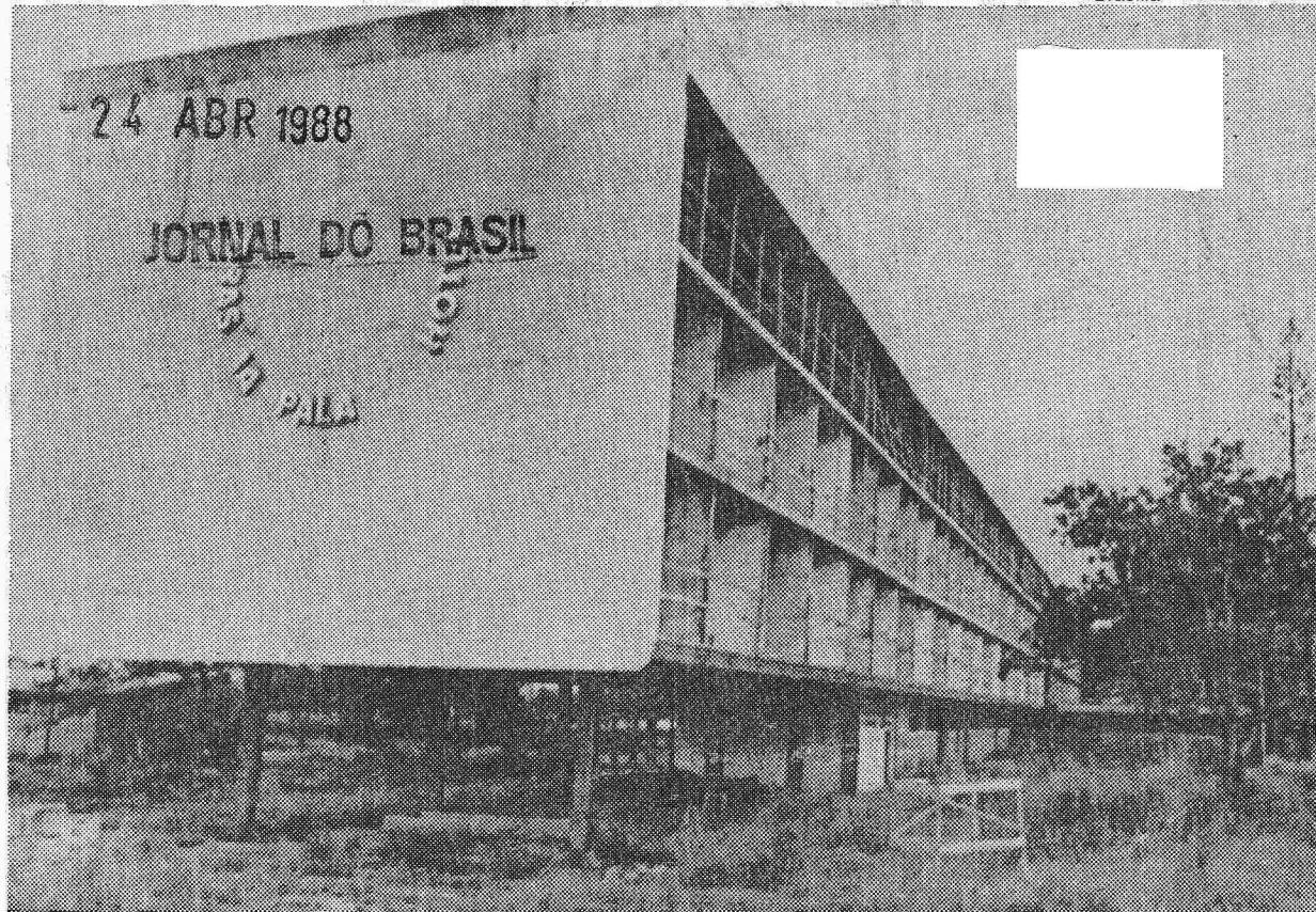
Resta só a carcaça do Brasília Palace: as obras custarão cerca de CZ$ 500 milhões
