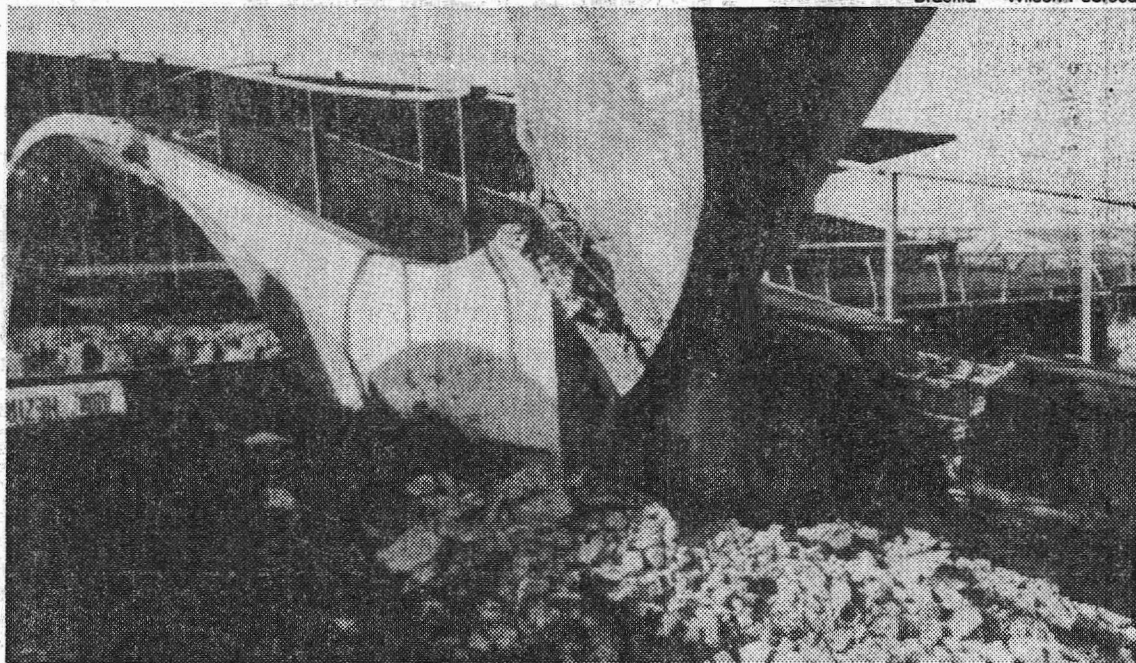
A passarela do autódromo será totalmente destruída até o fim da semana
