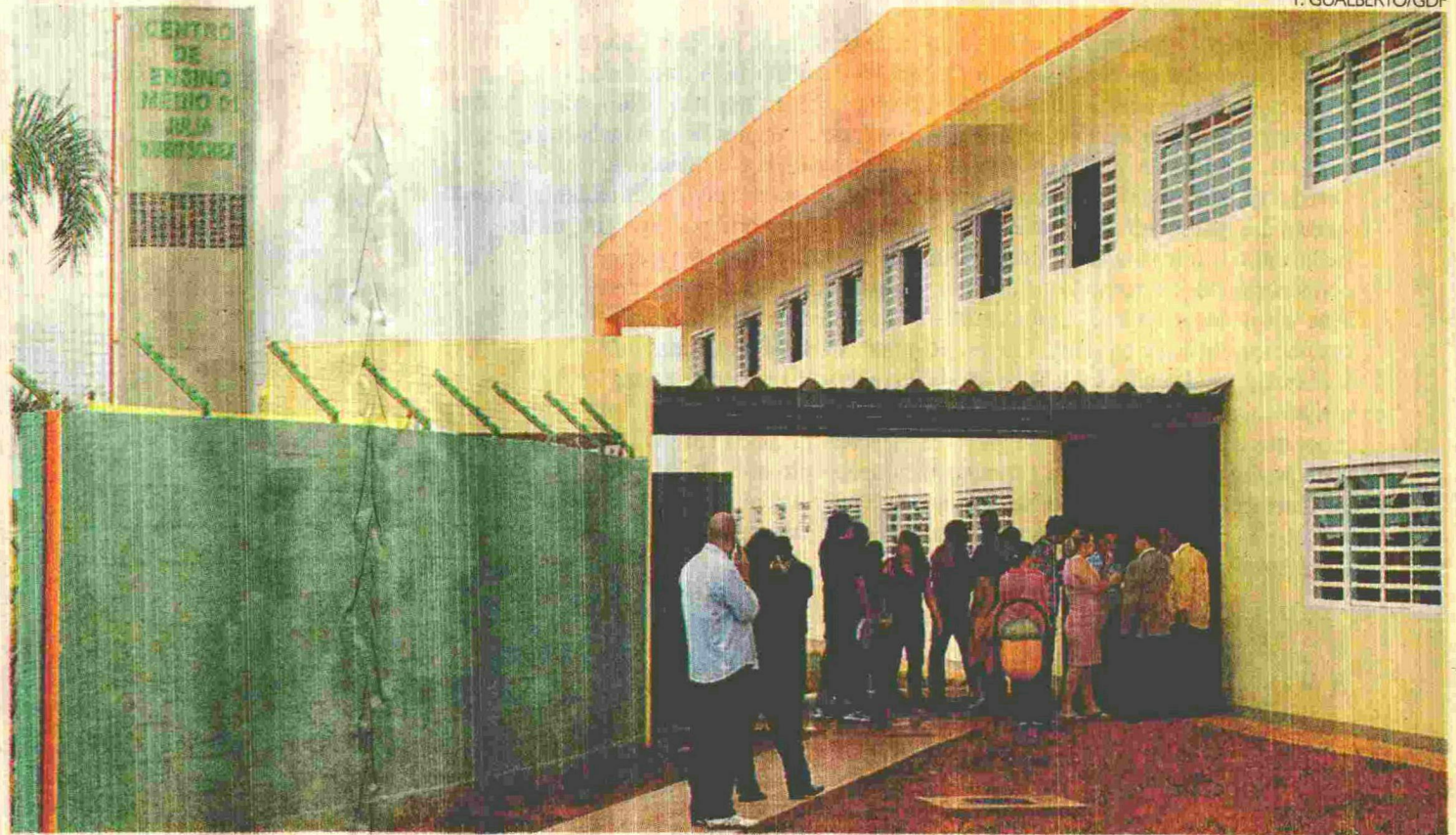
■ AGORA DE ALVENARIA, A ESCOLA JULIA KUBITSCHKE ATENDERÁ ALUNOS DOS ENSINOS MÉDIO E FUNDAMENTAL: OBRA CUSTOU R$ 3,744 MILHÕES
