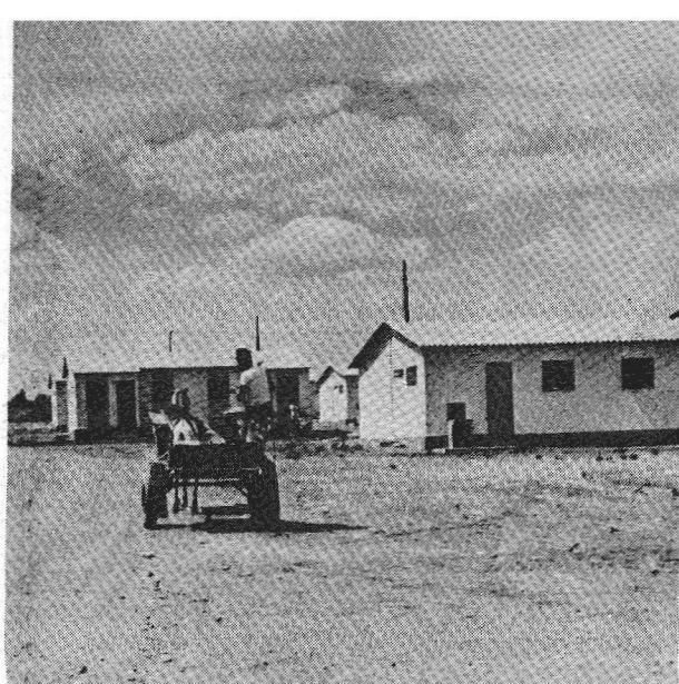
As casas começam a perder o reboco
