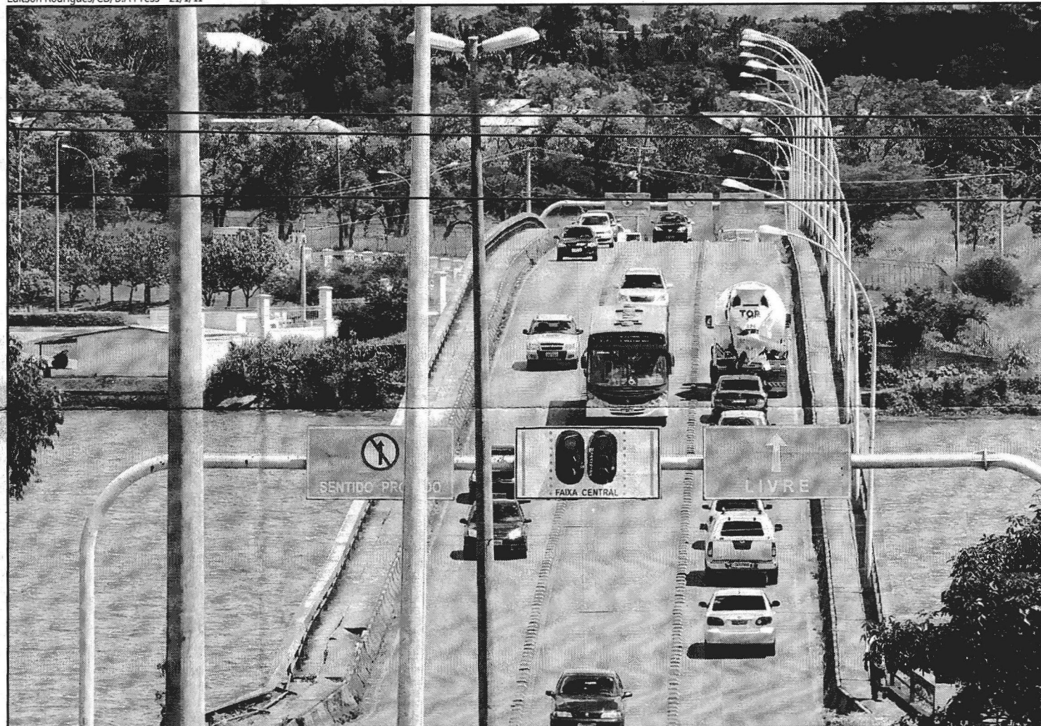
Projetado por Niemeyer, o trecho batizado em homenagem ao marechal existe desde 1976 e faz a ligação entre a 602 Sul e o Pontão: ecos da ditadura
